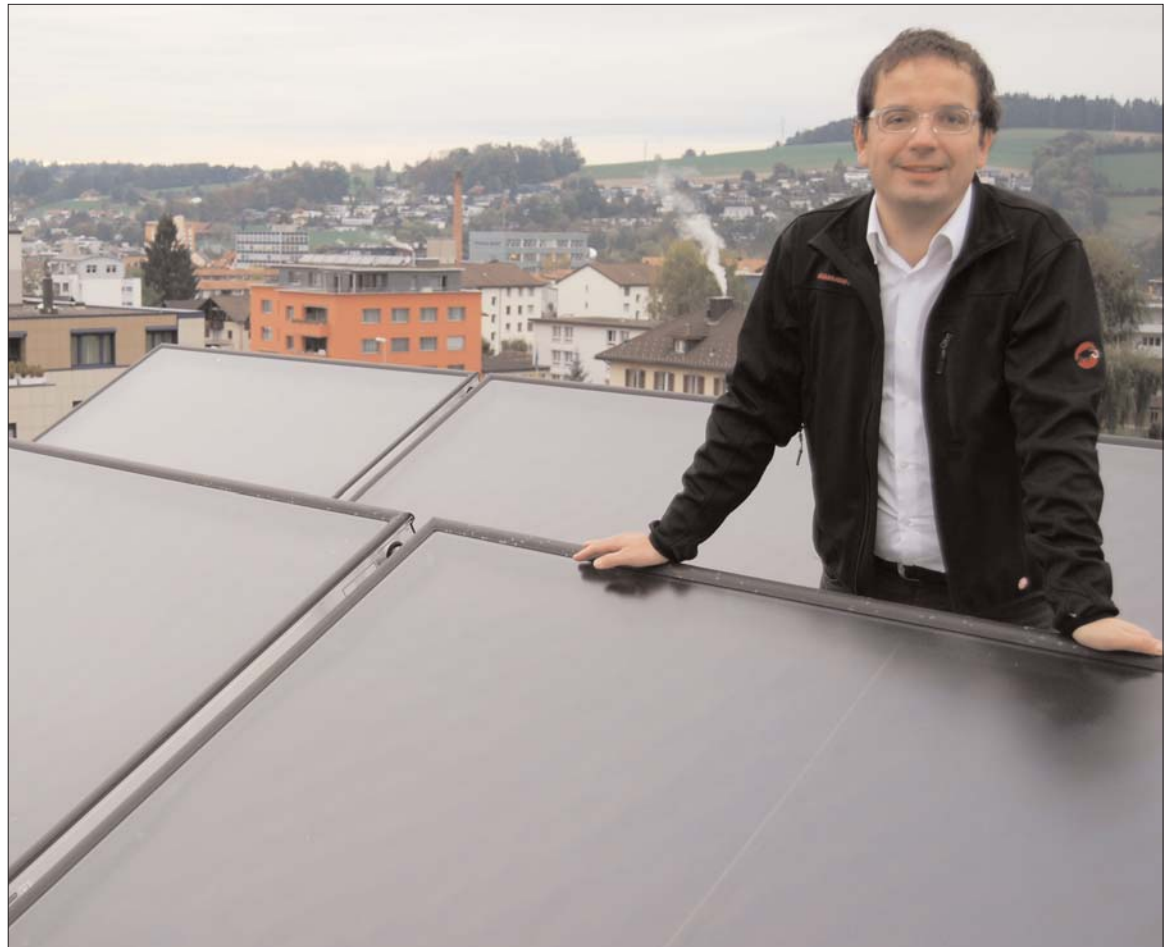
Energieberater Manfred Huber freut sich über die von der Gemeinde Baar geförderte Solaranlage auf dem Dach des Mehrfamilienhauses an der Ägerstrasse 7 in Baar.
